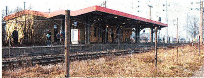
Umbauarbeiten der Bahnhöfe, wie hier Strasshof, sollen die Bahn attraktiver machen.
